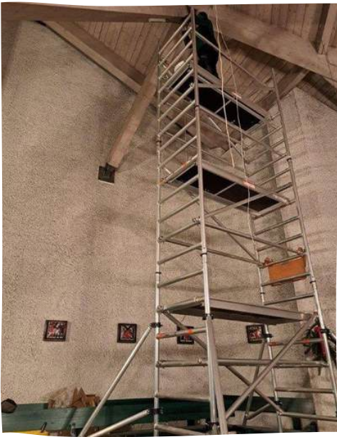
In luftiger Höhe: Montage der neuen Kreuzwegbeleuchtung!
